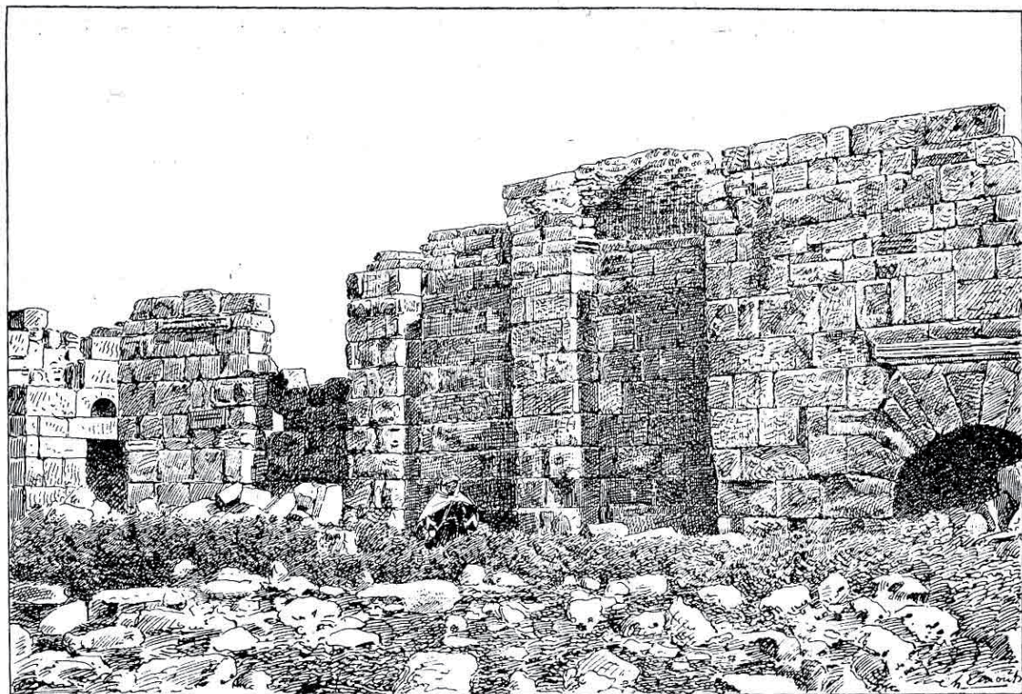
FIG. 163. — Forteresse de Mdaourouch (vue intérieure).
