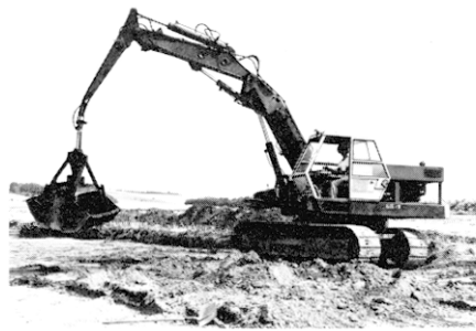
Fig. 4 - Emploi d'engin mécanique pour les grands décapages - Vallée de l'Aisne.
