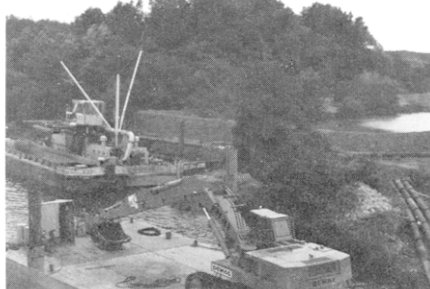
Fig. 3 - Surveillance des travaux de dragage de l'Oise.
